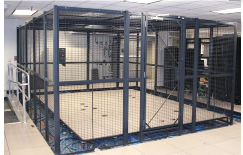
Cage de sécurité dans le centre de données
